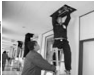
▲大活躍のPTAの皆さん。1階から3階、体育館など、校内中の天井に配線します。
